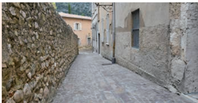
PAVAGE DE LA RUELLE DERRIÈRE LA CHAPELLE
