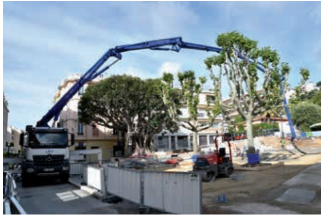
La chape de béton a été coulée après la réfection complète de tous les réseaux.
