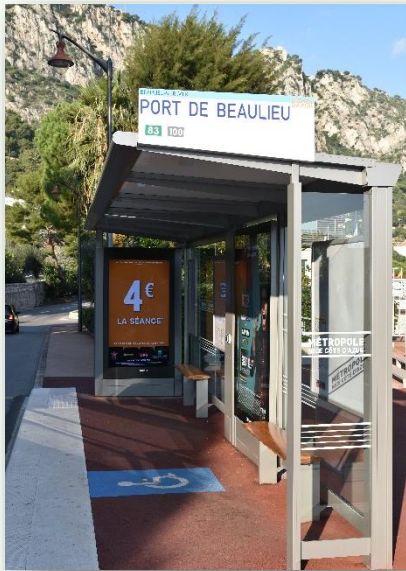
Remplacement en 2018 des abris-bus. Ici boulevard Maréchal Leclerc
