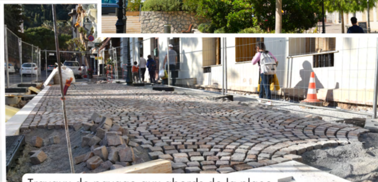
Travaux de pavage aux abords de la place
