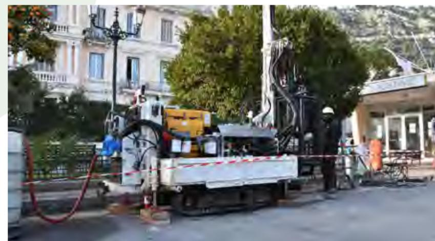
Forages de test sur le parking de la gare SNCF : sondage des sols en vue du projet de parking sous-terrain.
