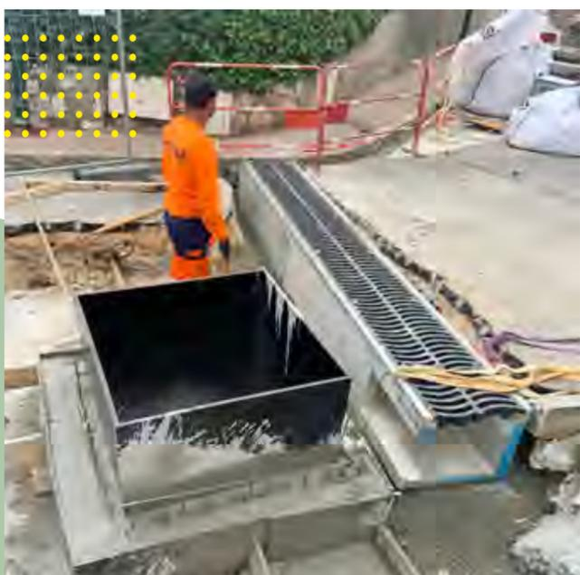
Installation d'un caniveau grille rue André Cane pour canaliser les eaux pluviales. Cet équipement permet de diminuer les risques de débordements en cas de fortes pluies.
